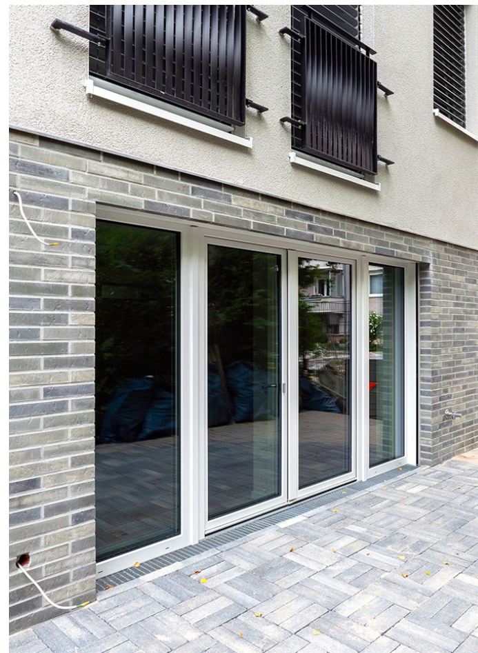
Auch die Außenfassade wurde modernisiert.
