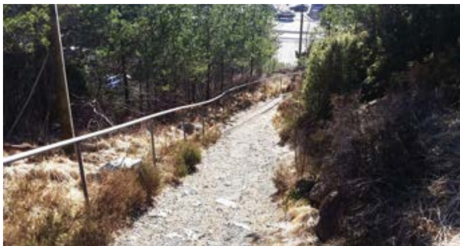
Alle bilder er fra snarveiprojekt i Trondheim i regi av Statens vegvesen
